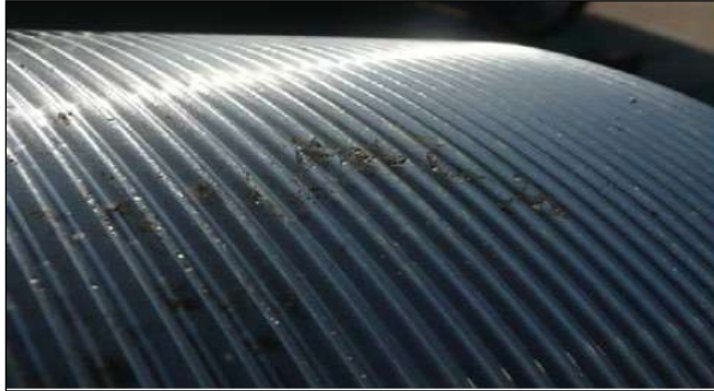
Photo. 7 Pitted Threads/ Picadura en las Roscas
